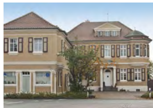
Sanierung „Altes Amtshaus“ Rhede
